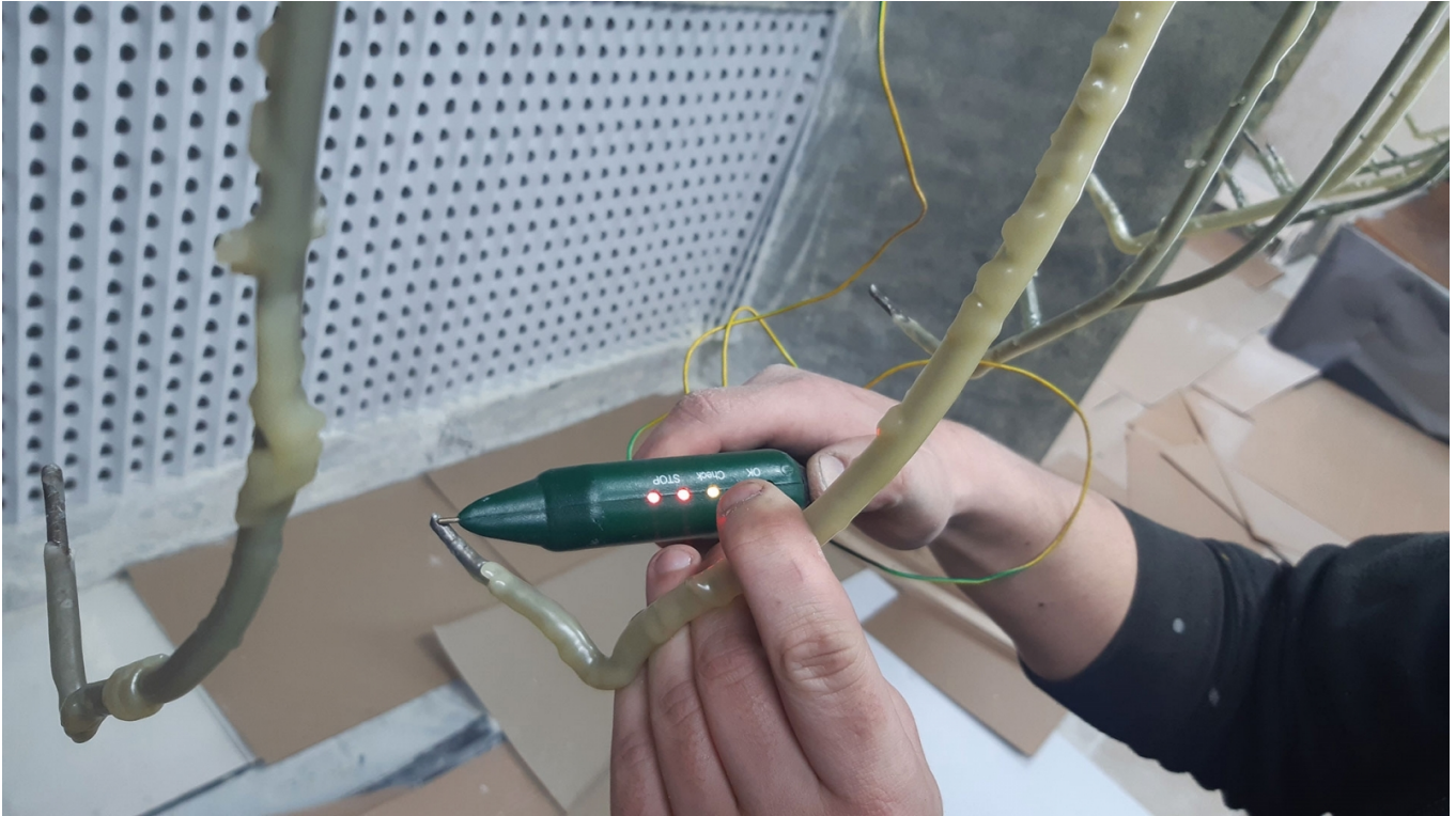
Рис. 6. Перевірка ефективності заземлення.
