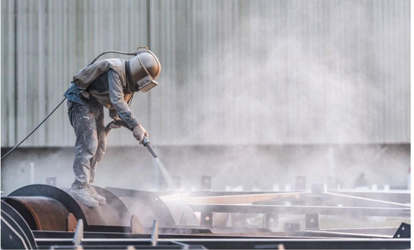
Струменево-абразивна обробка габаритних виробів
