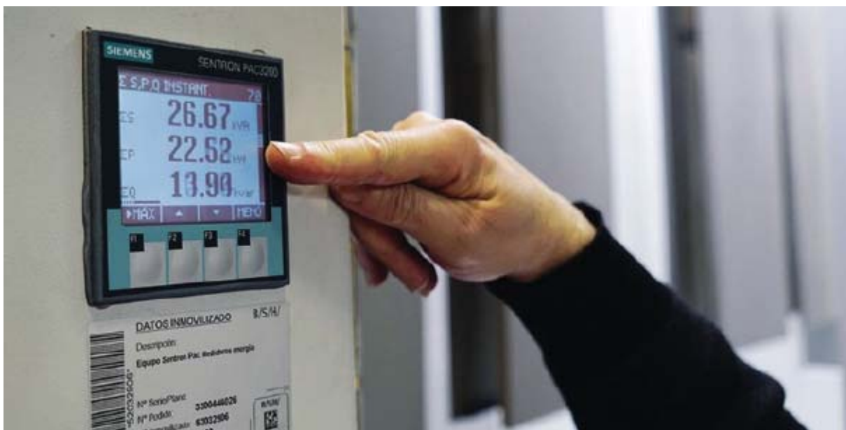
Фото. 2. Розхід стисненого повітря і енергії контролюються з допомогою Sentron PAC 3200 і системи BSH Wonderware ERP.
